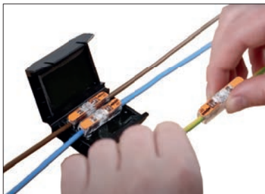
einfach zusammenstecken und in das Gel der aufgeklappten Box eindrücken
